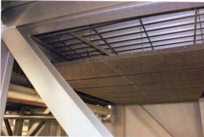
Absorptionselemente in der Dachkonstruktion
