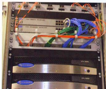
Der redundante Austausch der Steuer- und Audiodaten auf Basis des CobraNet wird mit HP procure 2626 Switchen realisiert
