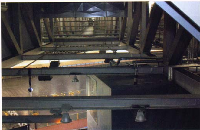
In der Dachkonstruktion sind Catwalks in alle Richtungen integriert
